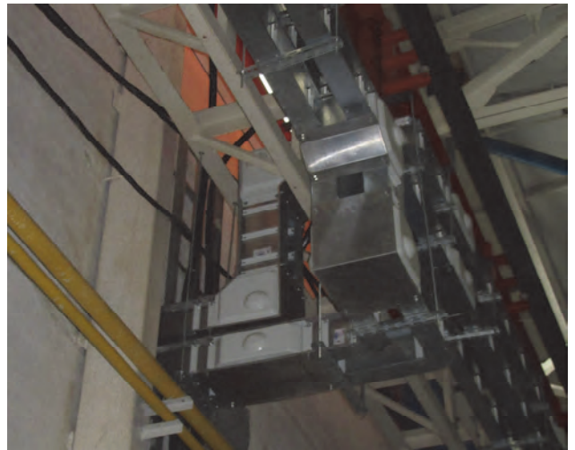
Крышка угловая – соединение любых двух секций шинопровода под углом 90°
