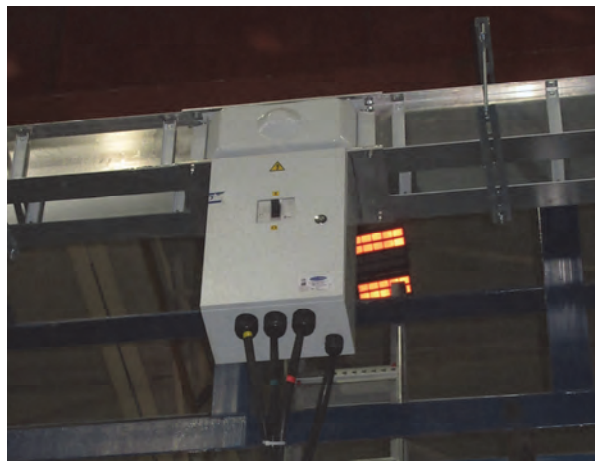
Коробка ответвительная вертикальная с автоматическим выключателем
