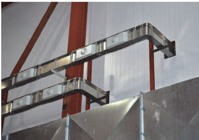
Секция угловая горизонтальная неравнобокая
