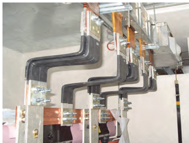
Рисунок 7 - Присоединение к трансформатору. ГРЩ, административное здание, метро Семёновская, г. Москва
