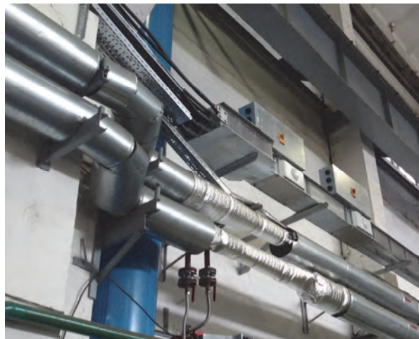
Секция переходная на кабель
