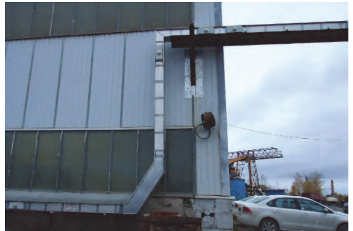
Прокладка шинпровода по улице в защитном кожухе
