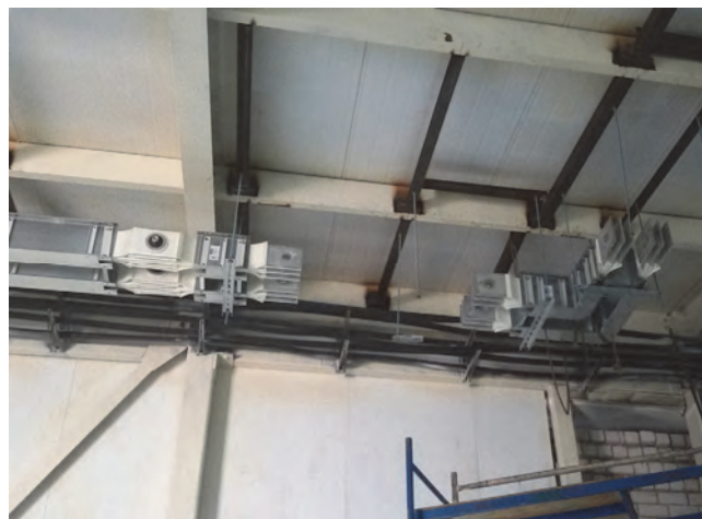
Замеры подгоночной секции
