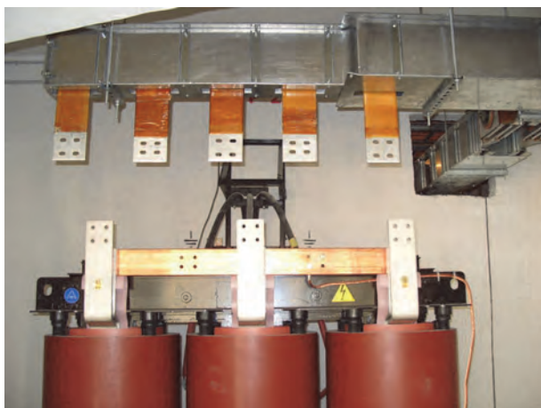
Рисунок 7 - Присоединение к трансформатору. ГРЩ, административное здание, метро Семёновская, г. Москва
