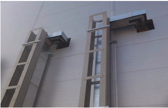
Прокладка шинпровода по улице в защитном кожухе
