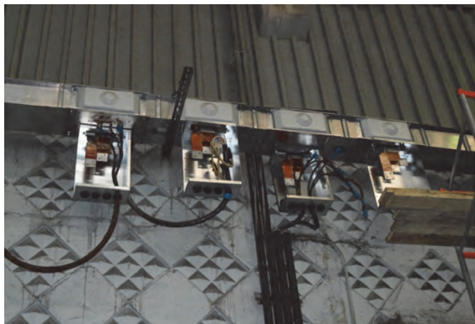
Коробка ответвительная вертикальная без автоматического выключателя
