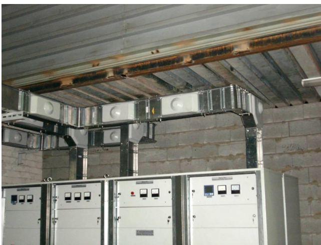
Рис.1 Применение комплекта крышек угловых У5137Р для разъёмного соединения шин секций шинопровода на РП18А ОАО «СОЭМИ».
