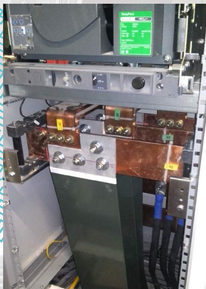
ЛЕНТА, г. Екатеринбург Магистральный шинопровод на 2000А и на 1600А
